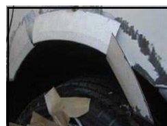
腐ったタイヤハウス サビ部分を完全に落とす。
