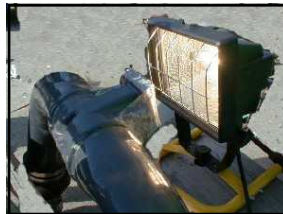
急ぐ時や気温の低い 時は加熱で硬化が早 くなります。 ( 50 で約20分 )
